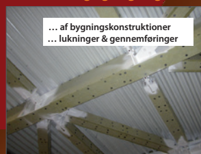
Brandisolering og -fugning
